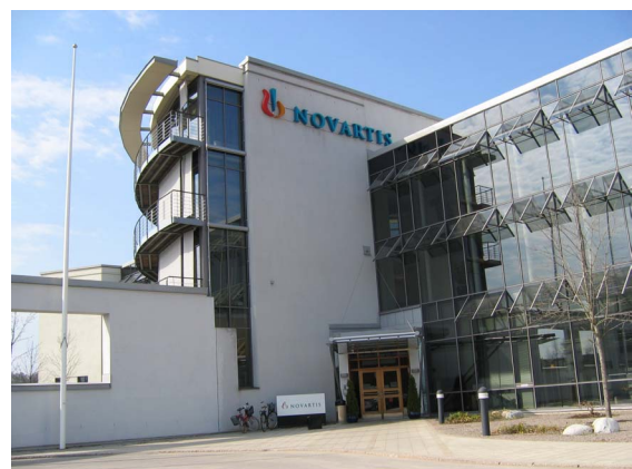
Här syns de snedställda glaserna som ska fungera som solavskärmning.
